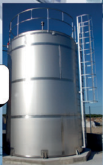
RESERVATÓRIO DE 1.000 M Reservatório 01 – Área da ETA Reservatório 02 – Bairro Boa Vista
